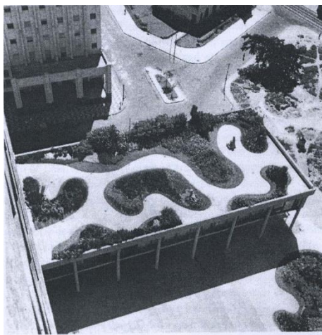
Fig. 5.25 The MES roof garden (Fraser 2000, p183)
