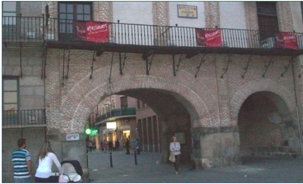
Figure 11 Casa de los Arcos
