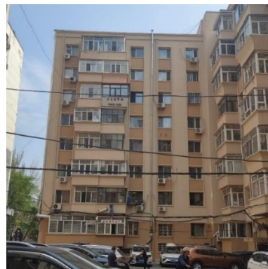
(d) Brick building
