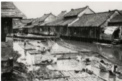
Figure 127 'Bamboevlotten aan de achterzijde van de Pintoe Ketjil te Batavia,' 1936, public domain, KITLV.
