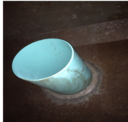
(d) Biofilm deposits on a SR inlet.
