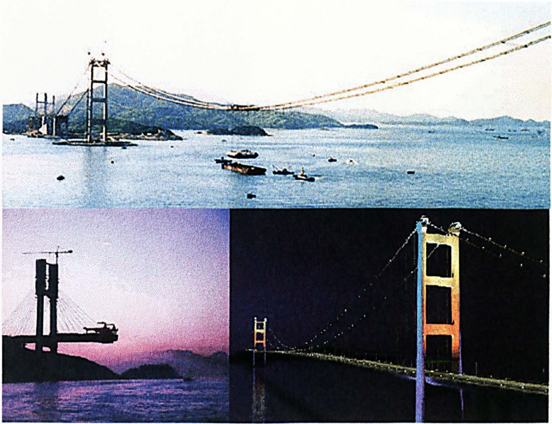
17a. Tsing Ma Bridge.
