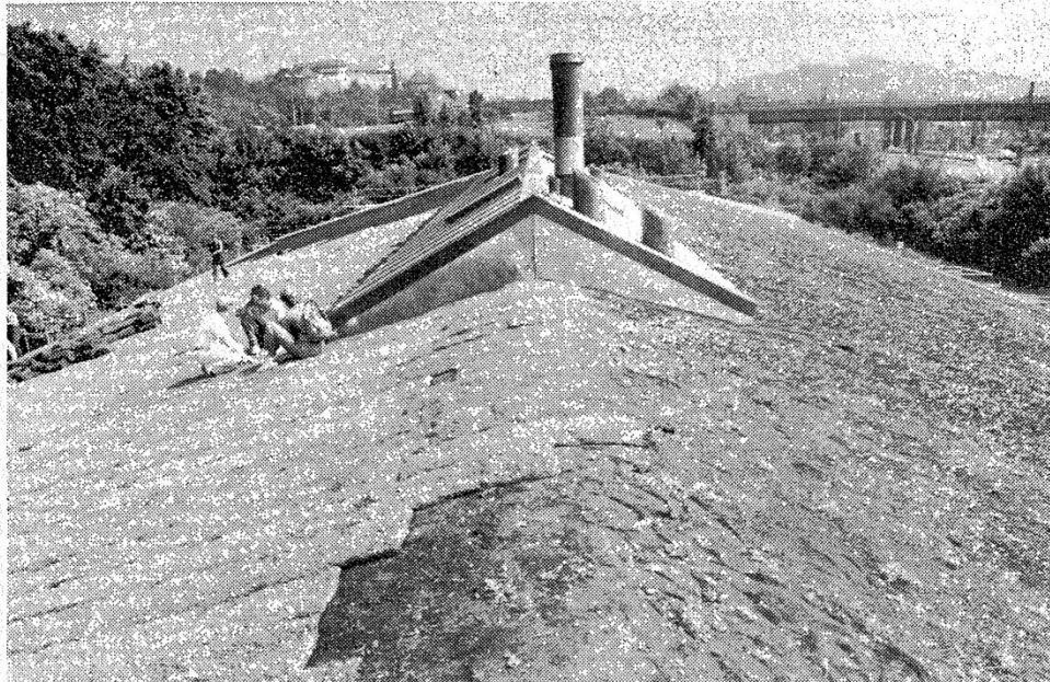
Die Unterschiede zwischen Nord- und Südseite zeigt dieses Bild: links verlegter Rollrasen, rechts noch weitgehend sichtbare Erdschicht mit den jungen Stauden und Kräutern. Bilder: Metz
