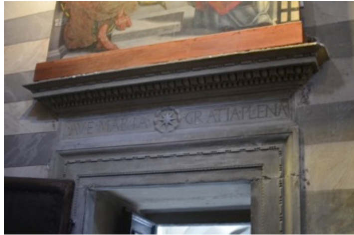
Figure 29: Oratory Doorway, Duomo di Volterra, Volterra
