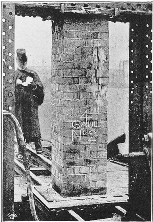
FIG. 2.—PIER NO. 4. GAUGE AT 110.
