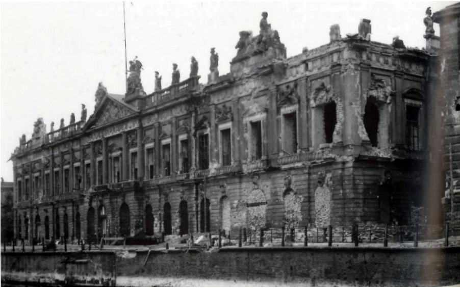
Figure 32, East façade of the Zeughaus after 1945. Photo: Müller, Das Berliner Zeughaus , 252.
